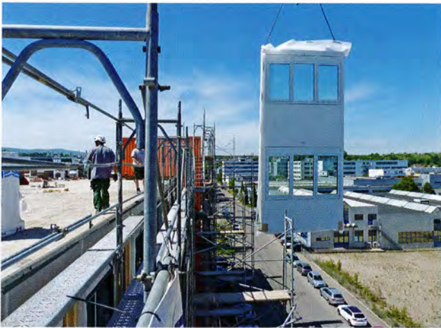
Die Ausführung der Fassade erfolgte schnittstellenübergreifend
