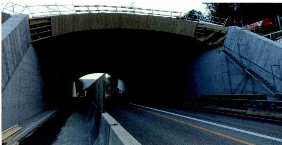
Die 17,4 Meter langen Träger überspannen jeweils eine Fahrrichtung der Autobahn, die bei Bedarf von zwei auf drei Spuren ausgebaut werden könnte.
