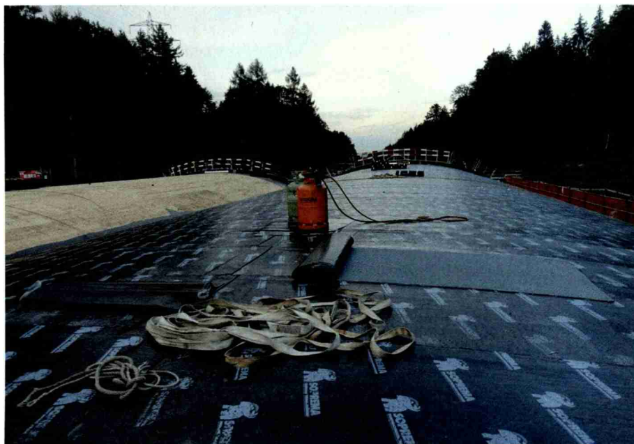
Die Holzbalken sind mit einer Lage aus Schichtholzbrettern überdeckt. Zum Schutz werden zwei Lagen Dachpappe sowie eine Spezialfolie aufgeklebt, die verhindern soll, dass Pflanzenwurzeln der künftigen Begrünung den Aufbau zerstören.
