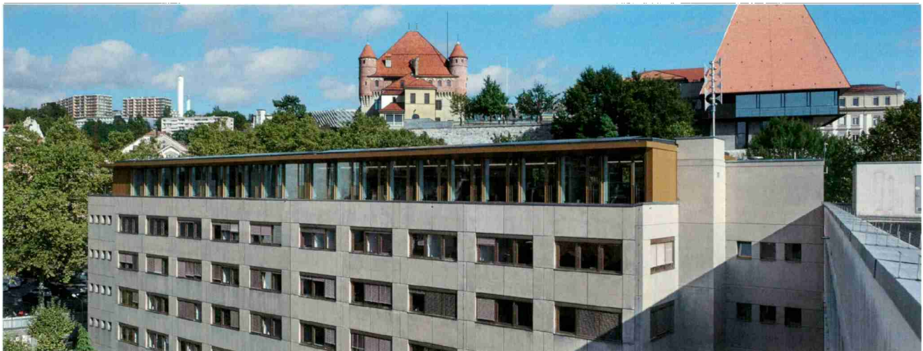
Gelungene Aufstockung eines Verwaltungsgebäudes, Lausanne, 2018.
