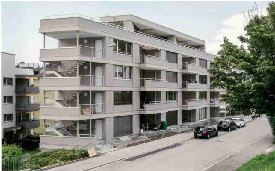
Aufstockung Wohnhaus Röschstrasse in St. Gallen.
