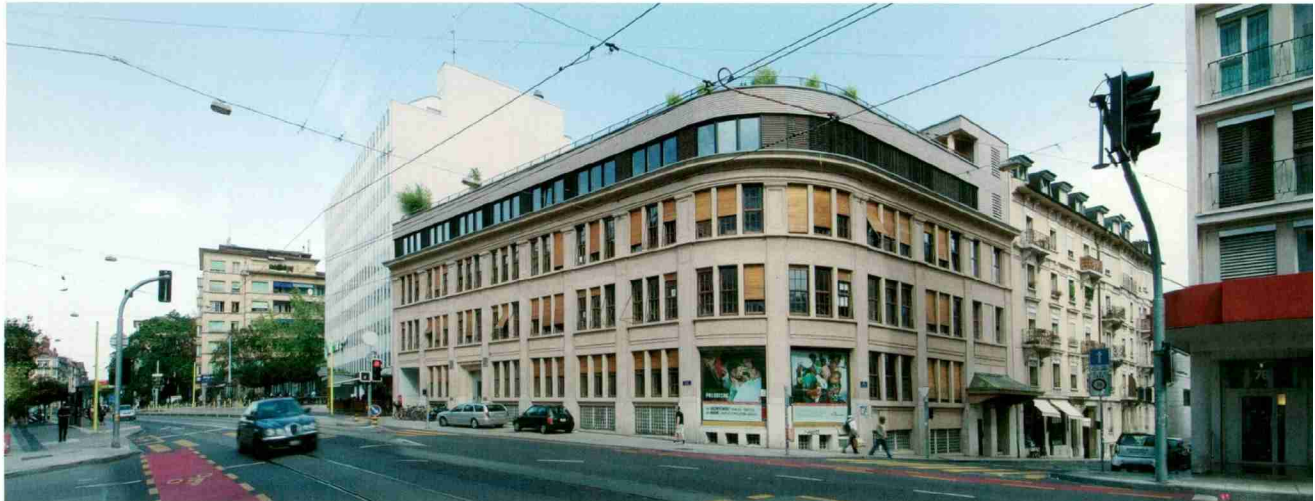
Aufstockung des Gebäudes «Médecins Sans Frontières». Architekt: Jean-Pierre Golinelli, Genf.
