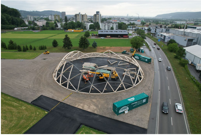
Bild 2: Montage des Domes in Pratteln auf dem ESAF Gelände
