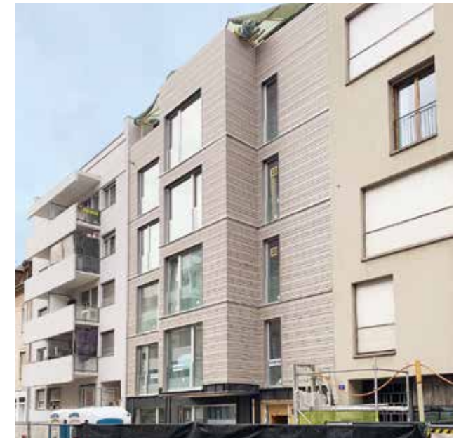
Abb. oben_Just-in-time-Lieferung und -Montage der Wand- und Deckenelemente.
