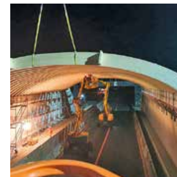
Abb. oben_Die 156 vorgefertigten Bogenträger geben dem Tragwerk der Doppelbrücke ihre Form.
