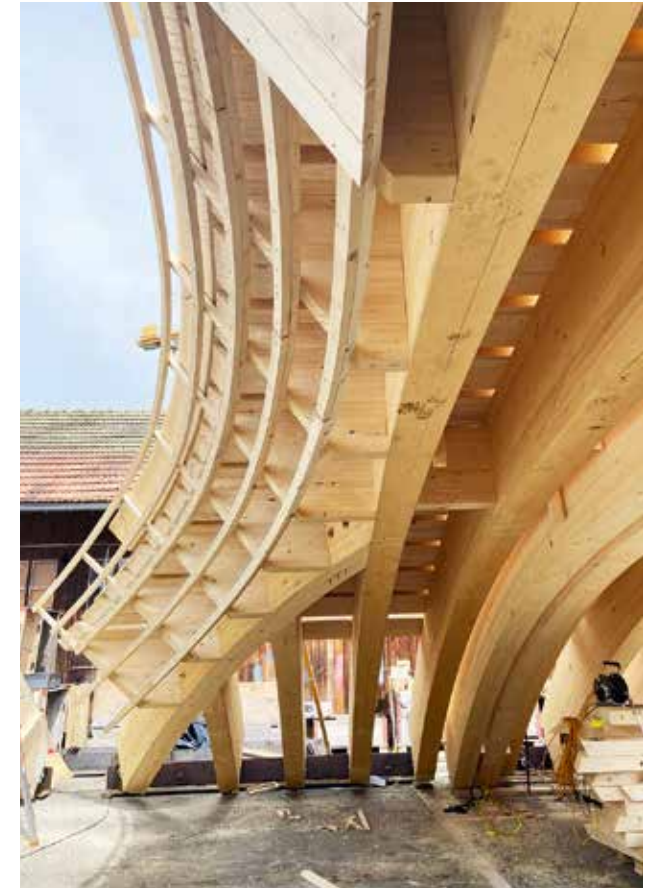
Abb. oben_Die 156 vorgefertigten Bogenträger geben dem Tragwerk der Doppelbrücke ihre Form.
