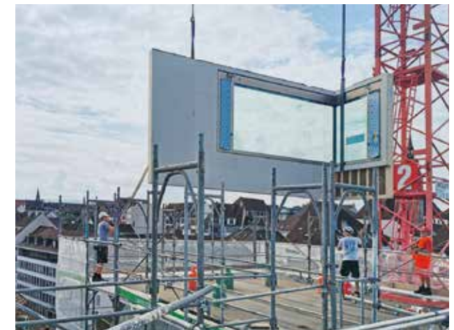
Abb. unten_ Montage der eckverglasten Fassadenelemente.
