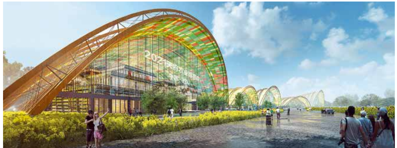
Abb. unten: Bogenträger aus Brettschichtholz mit Spannweiten von über 115 Metern überspannen die Hallen in Chengdu.
