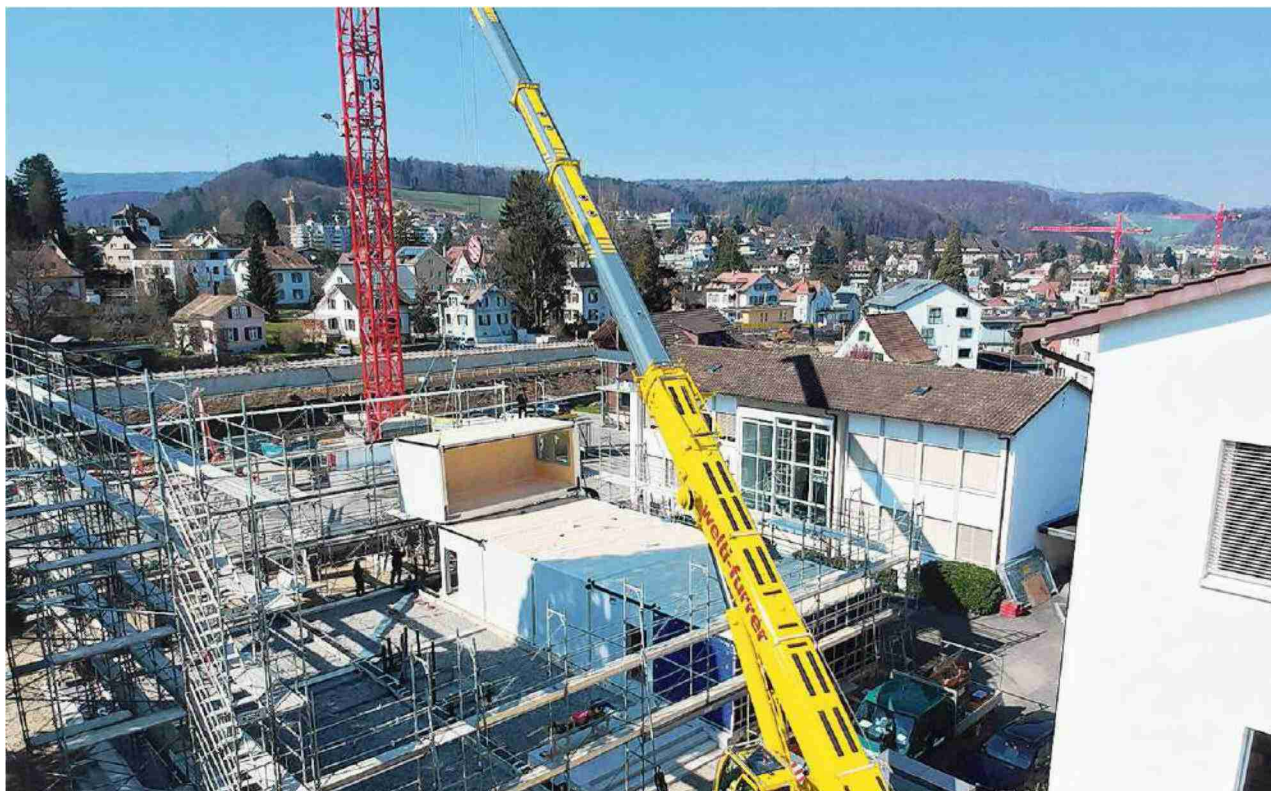
Die 36 Module werden mithilfe eines Mobilkrans an ihrem jeweiligen Standort platziert.
