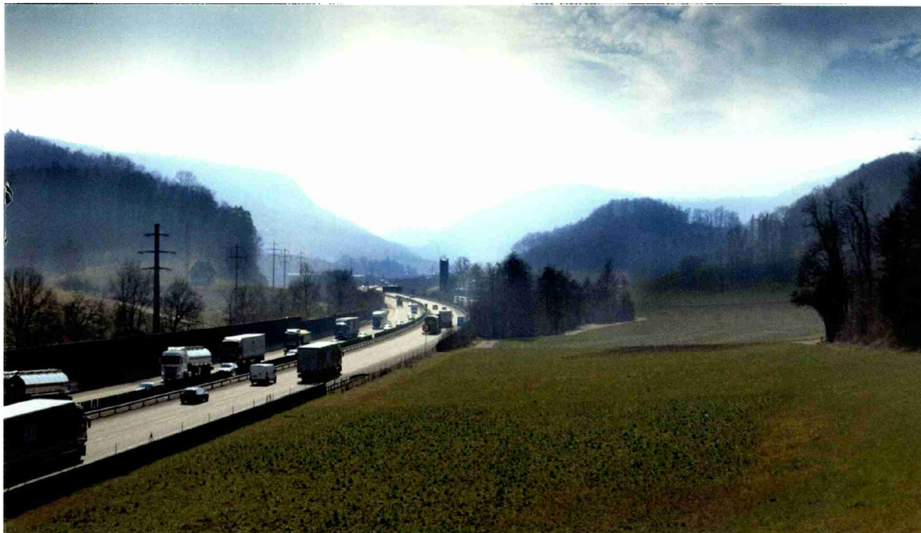
In der Nähe von Tenniken (BL) will das Bundesamt für Strassen eine Brücke für das Wild in die Landschaft stellen - aus Beton. Foto: Mischa Hauswirth
