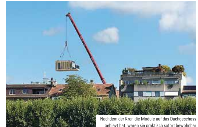
Prinzip Baukasten: Die Montage geht schnell und ohne belastende Baustelle vor sich.
