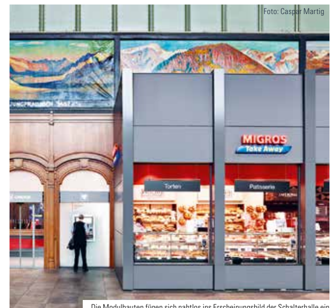
Die Modulbauten fügen sich nahtlos ins Erscheinungsbild der Schalterhalle ein
