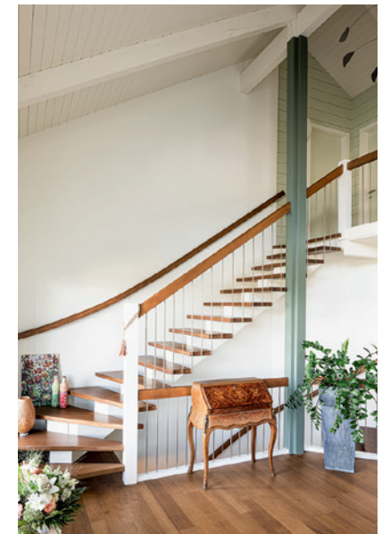
Abb. oben_ Die rund 30 bestehenden Treppenstufen wurden demontiert, geschliffen, versiegelt und wieder montiert.
