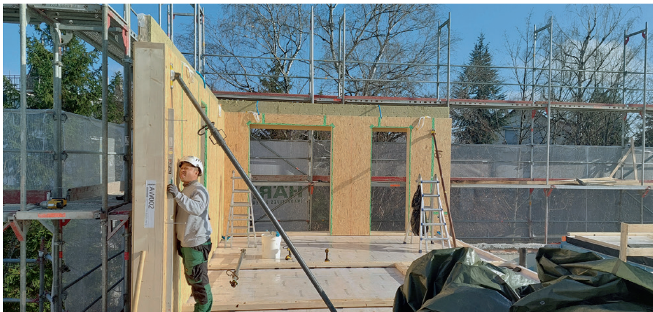
Abb. links_Montage der vorgefertigten Elemente an der Schulhausstrasse.
