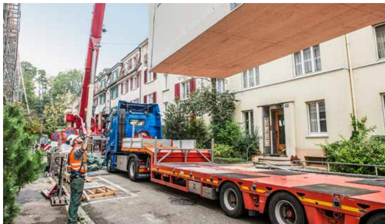
An einem einzigen Tag wurden die vier Zimmermodule aufgebaut.
