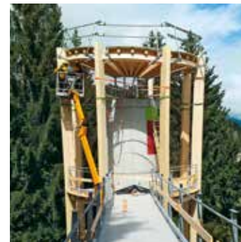
Abb. links_Der 1,56 km lange Steg verläuft in einer Höhe zwischen 2 und 28 m.
