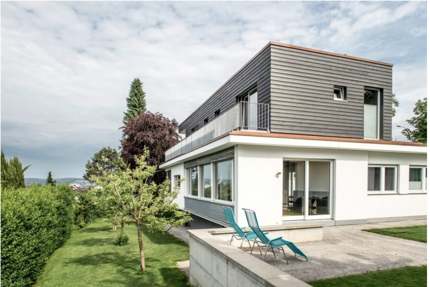
Aufstockung Fasanenstrasse Möhlin - vorher
